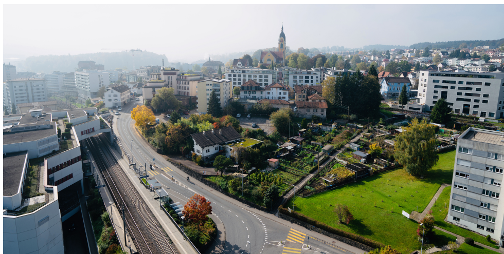
Abb. Areal «Sonne», Ansicht von Nordosten
