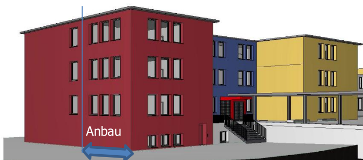
Abbildung 10: Ansicht Nord mit Anbau
