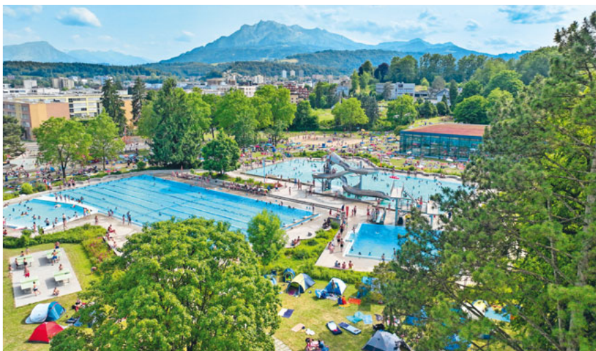
Im Frei- und Hallenbad Mooshüsli sind dringende Sanierungen angezeigt. (Bild: Gemeinde Emmen)
