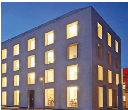
Das Haus ohne Heizung an der Emmenweidstrasse 58a. (Bild: Emanuel Ammon/Aura)
