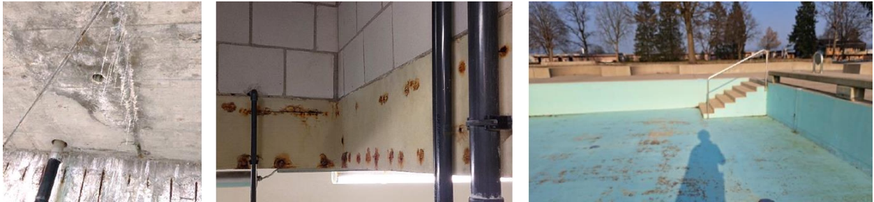
Abbildung 11: Beispiele aus den Bestandesaufnahmen - Stalaktitbildung, rostende Armierung und abblätternde Farbe
